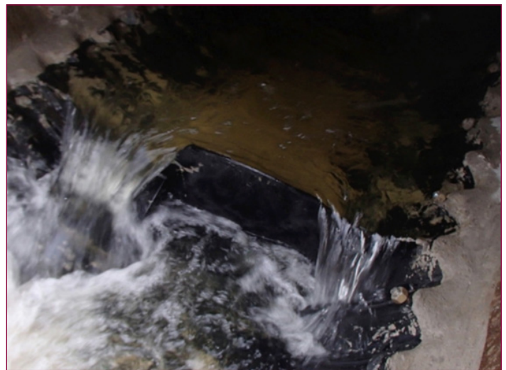
Eau passant en cascades à travers les passages principal et secondaire de l'échelle à poissons (Photo offerte gracieusement par l'ITTO)
