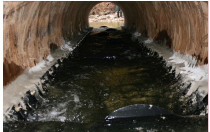
Vue vers l'aval de l'échelle à poissons sur place et à plein régime (Photo offerte gracieusement par l'ITTO)
