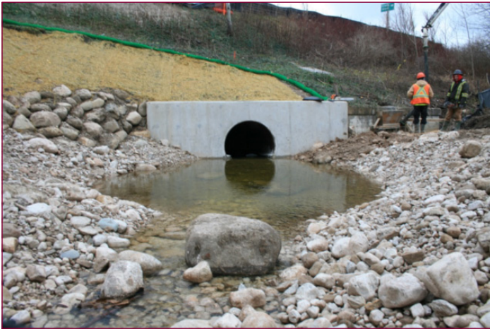
Vue en amont du nouveau ponceau (Photo offerte gracieusement par l'ITTO)
