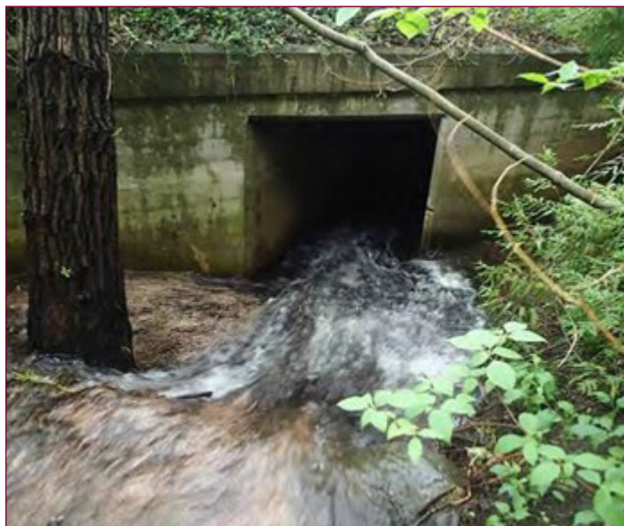
Entrée du ponceau d'origine de la rue Craig
